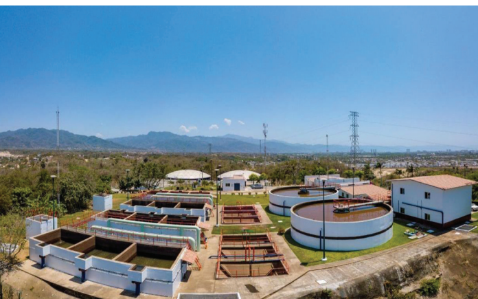
Figura 1. Foto de la planta potabilizadora Mojoneras, ubicada en la localidad Las Mojoneras, en el municipio de Puerto Vallarta, Jalisco. Imagen tomada de: https://www.seapal.gob.mx/rehabilita-seapal-filtros-en-planta-potabilizadora-mojoneras/
