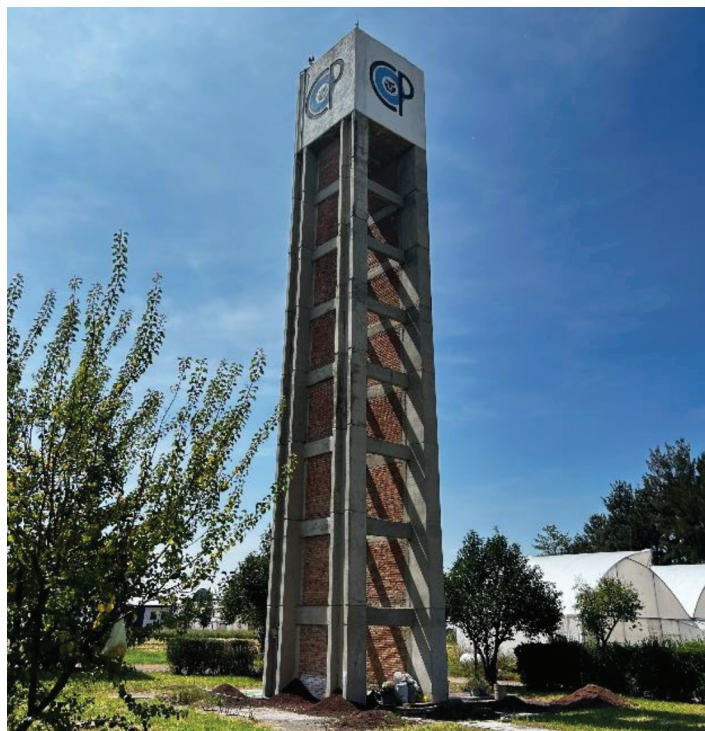
Figura 2. Torre de agua para almacenamiento y suministro de agua a inmuebles en el colegio de Postgraduados, Campus Montecillo. Texcoco, Estado de México.
