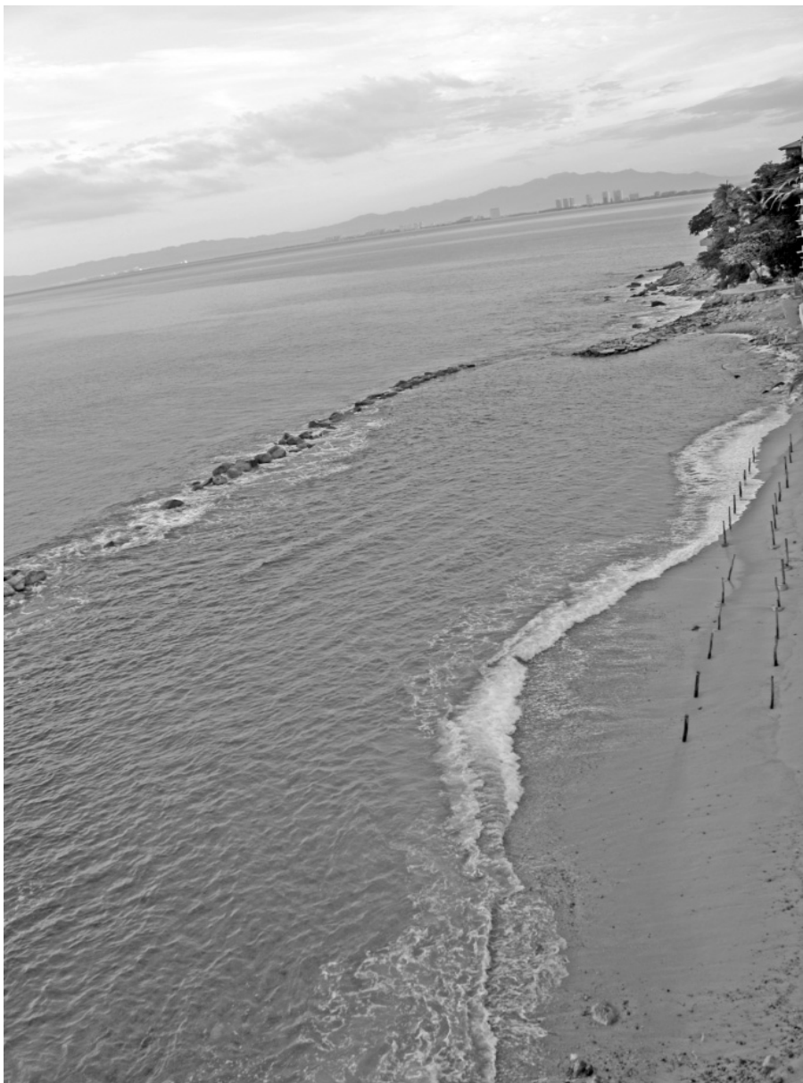
Fotografía 48. El Venado, es una playa ganada al mar y construida con escolleras y rompientes artificiales. En la parte superior de esta imagen se aprecian algunos edificios construidos en el área de la Boca Marina, 18 de octubre de 2009.
