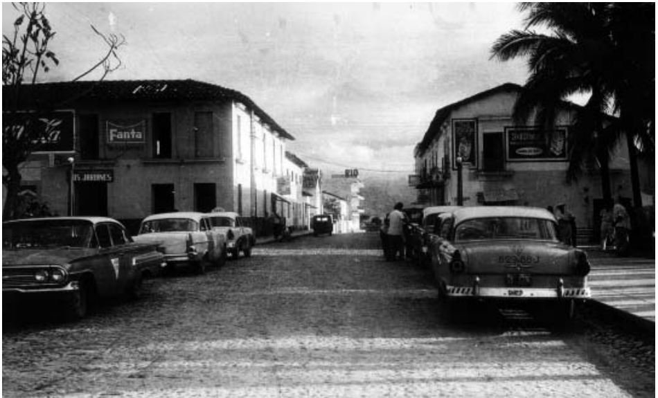
Fotografía 68. Calle Morelos, punto de confluencia de taxis. El edificio de la derecha es el restaurante-bar Punto Negro. Del lado izquierdo está el restaurante Los Jardines; la esquina era el negocio de Rafael Curiel, papá de Leocadio Cayo Curiel. Puerto Vallarta, Jalisco, 1956.
