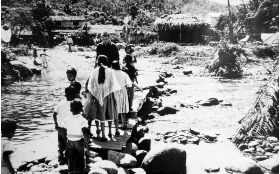
Fotografía 26. Antiguo puente de piedra soportado en vigas de madera y tablas, 1958.
