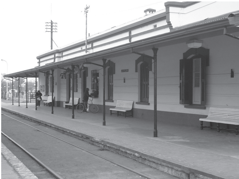
Estación de tren Los Toldos.
