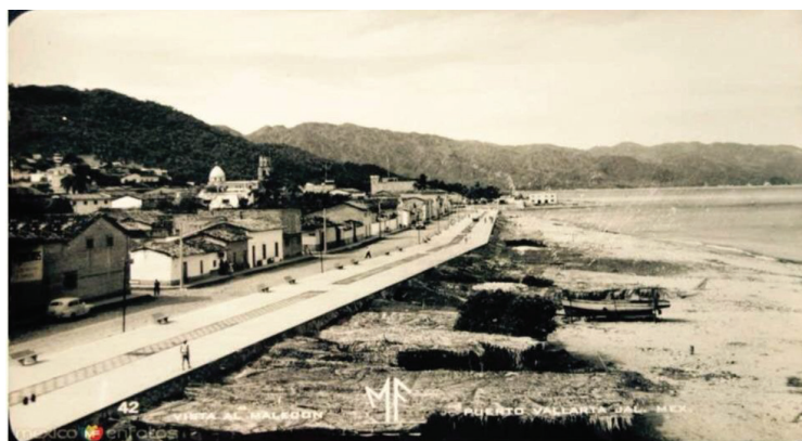
Figura 2. Vista al malecón
