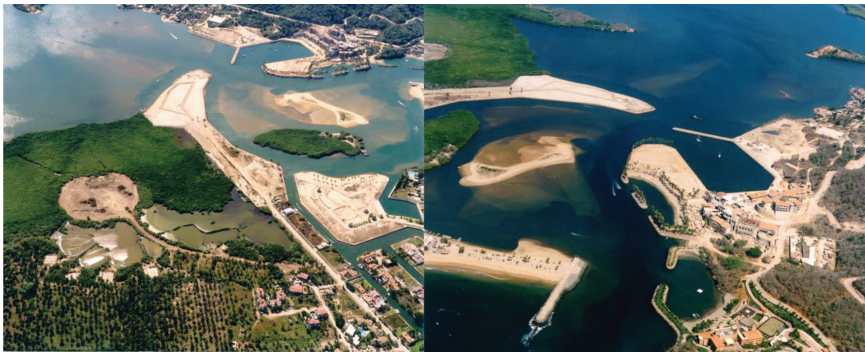
Figura 20. Avances de la construcción del hotel y aumento del azolvamiento de la laguna de Barra de Navidad durante 1995. Fuente: Ramiro Flores Vargas.
