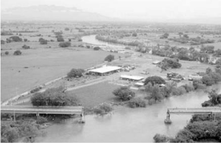
Imagen 13. Ejemplo del incremento de peso vehicular sobre el puente Ameca, que se vino abajo por sus años y poca atención de mantenimiento
