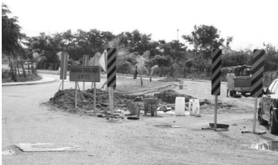
Imagen 5. Construcción de nuevas vialidades, con acceso a nuevas colonias de residentes flotantes y hijos
