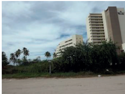
Figura 6.13 Zona hotelera ubicada en área de estudio. Fuente: Elaboración propia.
