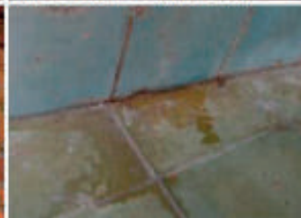
Casa la Escalera (ladrillo en pasta color azul)
