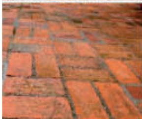
Casa Quinta de los Leones (ladrillo de barro cocido)
